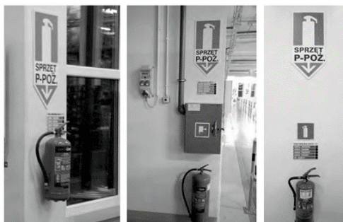
Rysunek 5. Przykład zastosowania znaków bezpieczeństwa w miejscach umieszczenia środków ochrony przeciwpożarowej. Źródło: CIOP PIB 2020. Na podstawie ramowych wytycznych – dobrych praktyk z dnia 14.12.2020 r. [29]
