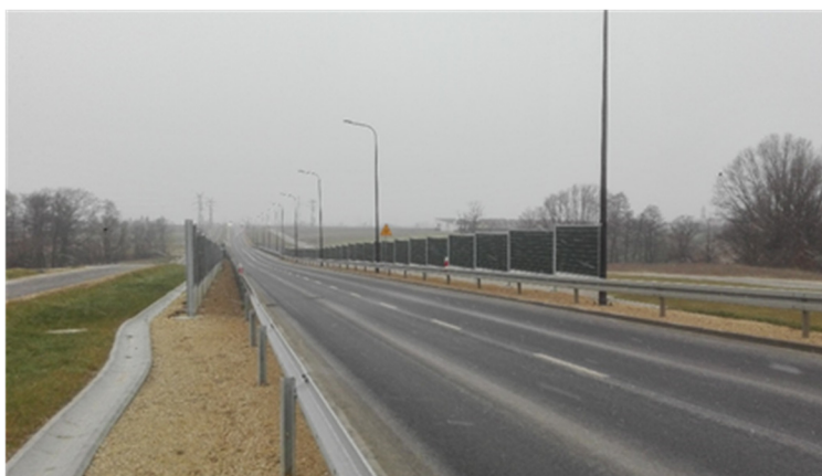
Rysunek 3. Ekrany akustyczne zainstalowane na badanym odcinku drogi
